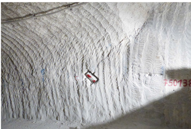
(a) 750-m-Sohle, Oststoß, Übergang der 1. südlichen Richtstrecke nach Westen zur Wendelstrecke
