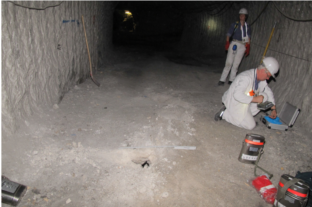
Abbildung 7: Sohlenaufwölbung vor ELK 4/750 mit angetroffener Lösung vor der Sanierung (Asse, 2016a).
